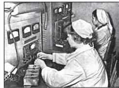
Процесс испытания первых транзисторов
