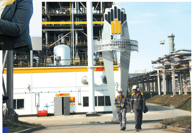
Установка каталитического риформинга задействована в проекте Татьяны Негурей (слева на фото) по очистке стоков.
